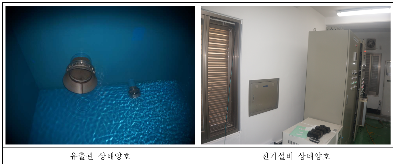
【사진 3.7】기전설비 손상사진
