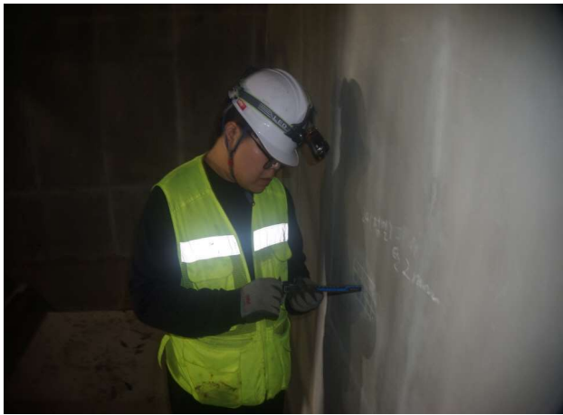
탄산화 깊이 측정
