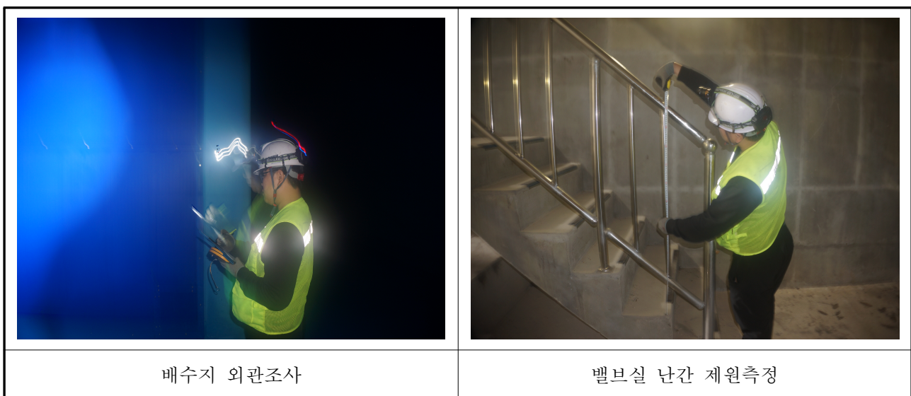
【사진 3.1】 시설물 외관조사
